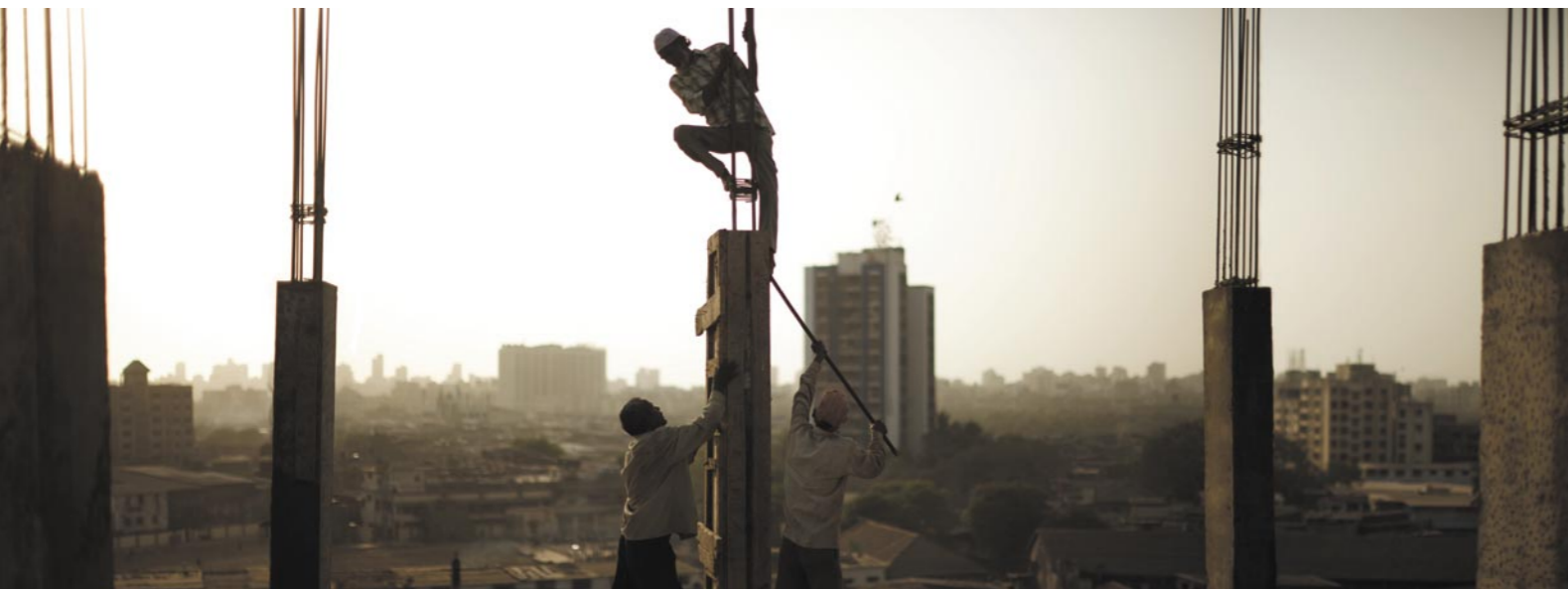
Rakennusmiehet töissä Dharavissa. Mumbai, Intia.
